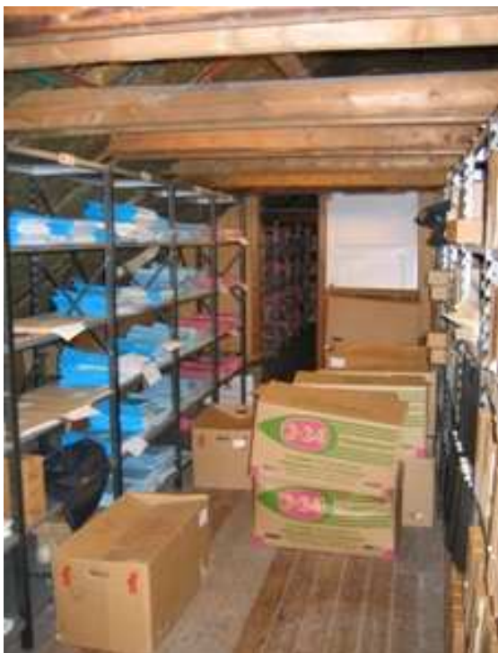
Sådan bør et arkivlokale ikke se ud. Sager står på gulvet i flyttekasser, det er svært at komme til og holder taget tæt i regnvejre?
